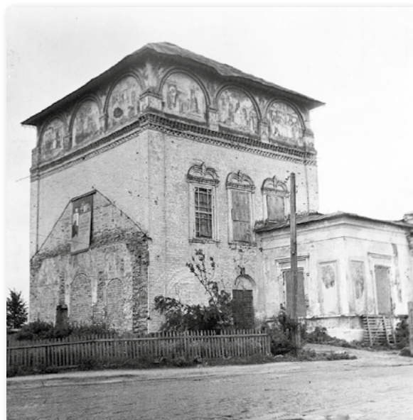
Никольская церковь. Фото 1960 г.
